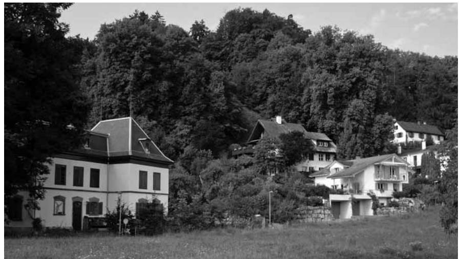
Die Remise beziehungsweise das Kutscherhaus wurde nach den Plänen des renommierten Architekten F. Hahn (1843–1925) im Jahre 1896 errichtet.
